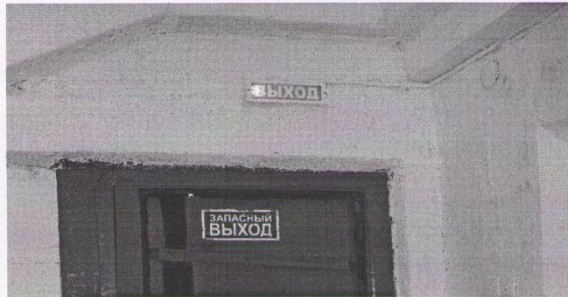
№ 20 эвакуационный выход 1эт
